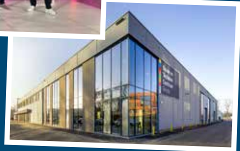
Het Bouw en Techniek Centrum in Breda in gebruik
